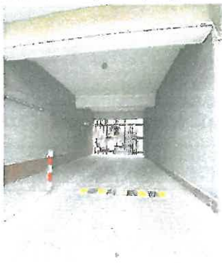
Widok na bramę przejazdową pod budynkiem
