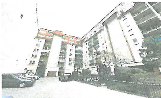
Widok elewacji wewnętrznych budynku
